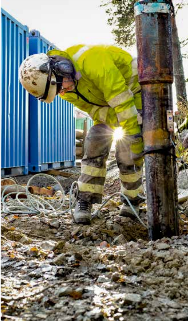
Verifiering av bärförmåga.
