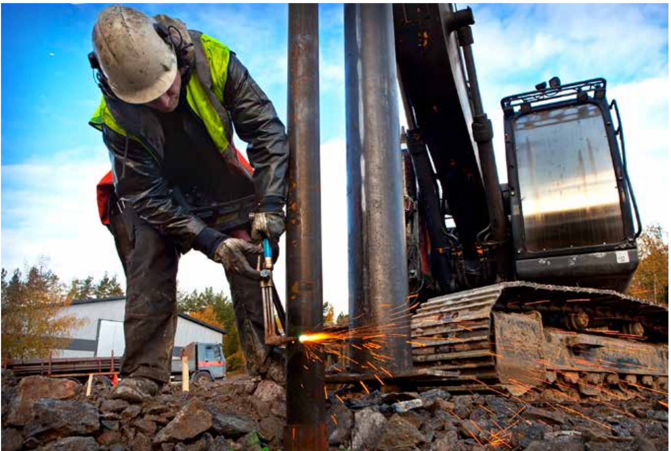
Kapning med gasskärare.
