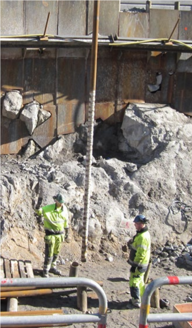
Rakhetskrav på stålkärnan underlättar installation.
