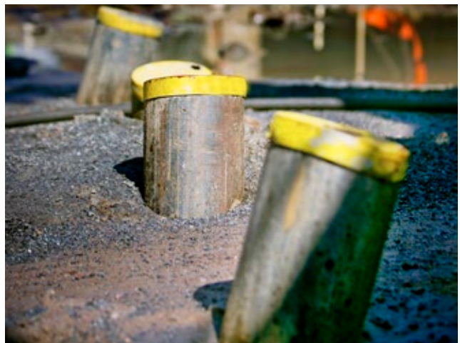
Höga rakhetskrav och snäva toleranser på rörens ovalitet underlättar installation.
