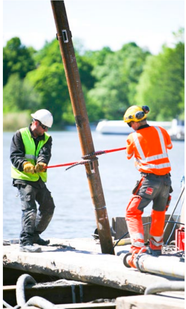
Åtdragningsmoment min 700 Nm.
