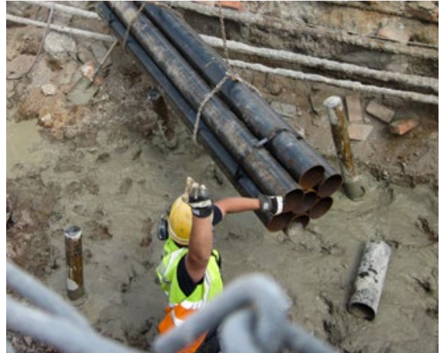
Foderrören levereras i längder om 3000 mm eller 6000 mm.
